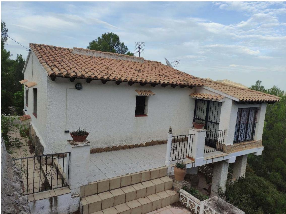
*IMAGEN\_05. Perspectiva de la vivienda tomada de la fachada orientada hacia el sur. En esta fachada se localiza una pequeña terraza. Se observa que la cubierta se resuelve mediante teja árabe y los cerramientos de las ventanas son de madera.*
